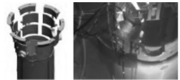
図4 炉心上部バレルの切断
