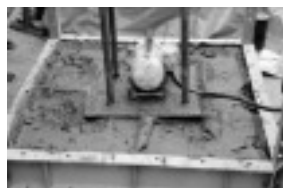
(b) 固化盤の打込み
